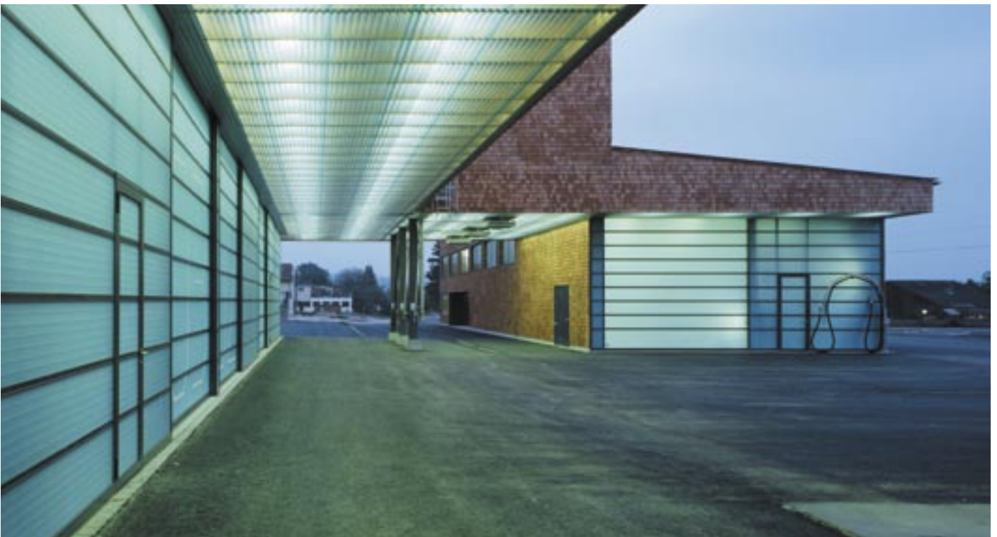
Durchfahrt und Vordachbereich Seite Werkplatz
